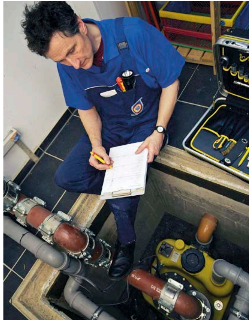
Damit die braune Brühe im Keller keine Chance hat, ist zuverlässiger Schutz durch Rückstauverschlüsse und/oder Pumpen unverzichtbar.
